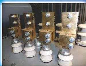
Данная опция помогает быстро и без дополнительных аксессуаров и аппаратов определять температуру на контактной площадке силового трансформатора, тем самым помогая эксплуатирующей организации предусмотреть аварийную ситуацию, и соответственно сохранить работоспособность трансформатора с масляным охлаждением.
